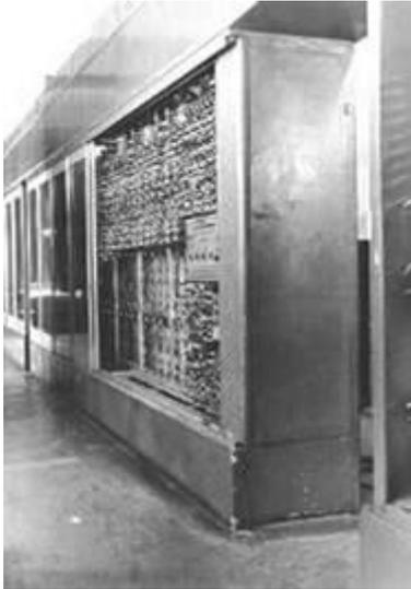
Рис. 4. Часть большой электронной счетной машины. 1952–53 гг.
